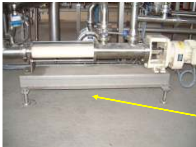
Montage einer Produktpumpengruppe auf Edelstahlrahmen mit Schaltern und IDMs
