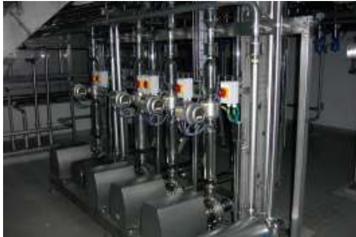
Montage einer Produktpumpengruppe auf Edelstahlrahmen mit Schaltern und IDMs
