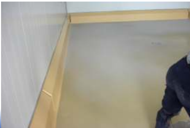
Hygienische Installation einer Anlage auf sauberem, gut zu reinigenden Boden (System hier: Ucrete)
