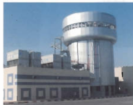
Dieser Turm beherbergt nicht wie man meinen sollte eine zentrale Kontrollwarte, sondern das Eissilo
