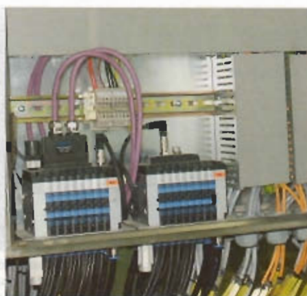
Signale gehen in Eilon Tavor nur noch digital über Feldbus
