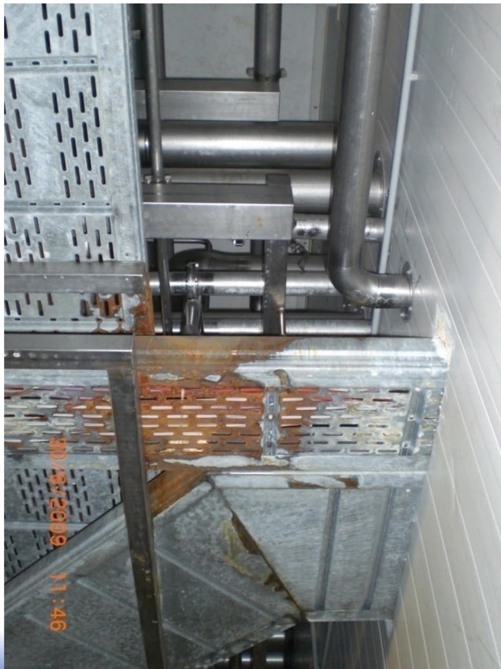
Installation einer Kabelbühne unterhalb einer flüssigkeitsführenden Rohrleitung mit Ventileinbau:
