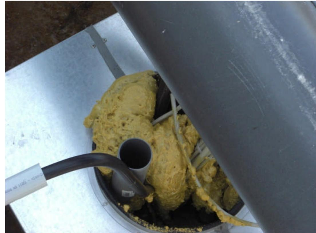
„Versuch der Abdichtung“ einer Rohrdurchführung für Kabel durch eine Wand (ohne Worte!!)
