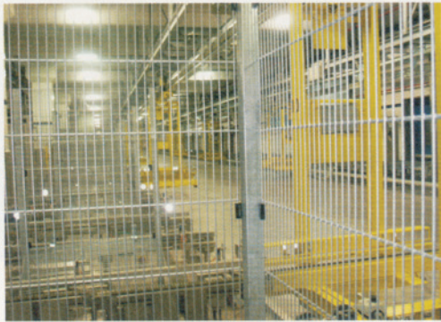
Die EHB erledigt alle innerbetrieblichen Transportvorgänge
